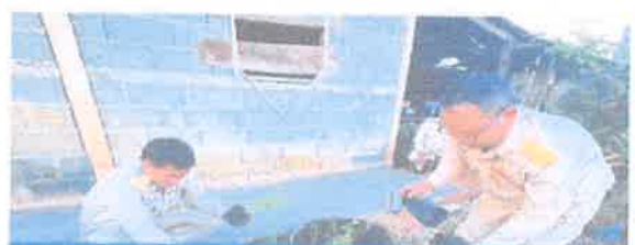
พช.นครพนม บุคลากรหน่วยงานภาคี ร่วมสนับสนุน ปรับปรุงซ่อมแซมบ้านครัวเรือนเปราะบางตามโครงการ... 18 มกราคม 2567 / ☎ 22:46 น.
